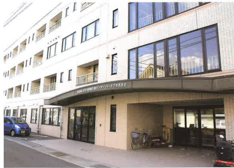
在宅生活復帰支援センターハートフル済生会。松山病院や老健にぎたつ苑の隣接地に平成15(2003)年開設された。要介護、要支援状態にある高齢者やリハビリが必要な人たちのために居住機能と生活支援機能を備え、現在、整備が進むサービス付き高齢者向け住宅の先駆けとも言える施設だ
